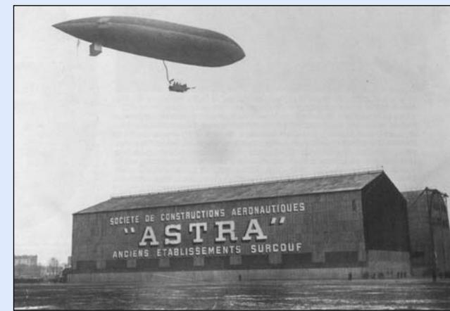
Las pruebas de recepción del “Astra-Torres XIV” en julio de 1913 constituyeron un nuevo éxito: se bate el record mundial de velocidad de un dirigible, alcanzando los 83,2 km/h. El Almirantazgo encarga el “Astra-Torres XVII” de 11327 m<sup>3</sup> y el “Astra-Torres XIX” de 3960 m<sup>3</sup>.
